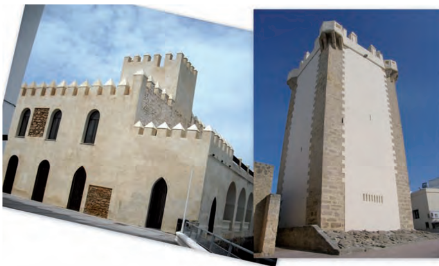
Imagen 1. Los hitos patrimoniales de Conil y Chipiona, la Torre de Guzmán y el Castillo de Chipiona convertidos en Centros de Interpretación
